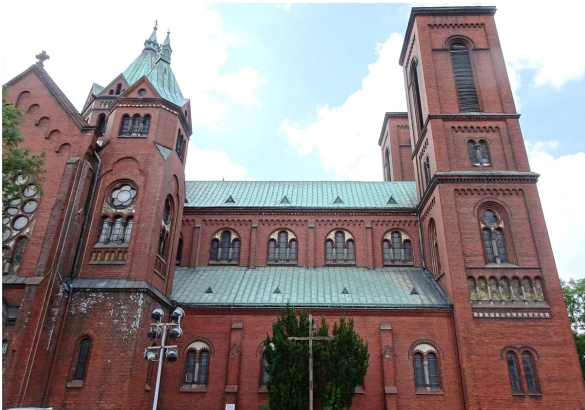
Fot. 2. Elewacja wschodnia budynku kościoła, widok na wieże frontowe
